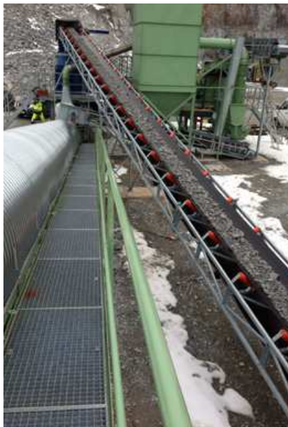
Förderband im Kalkwerk (Quelle: ITC AG)
